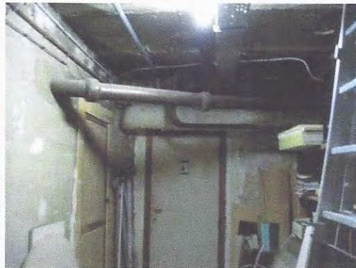
Photo 09 dans le couloir vers cage d'escaliers
