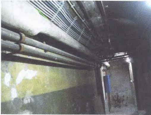
Photo 08 : dans la couloir
